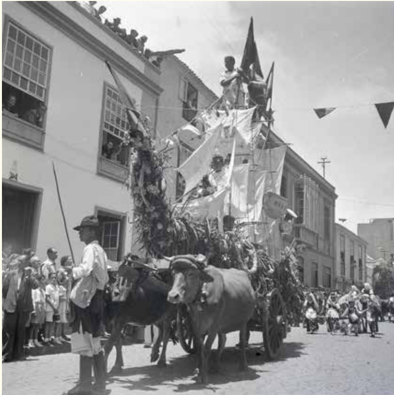
El Barco de El Hortigal navega sobre adoquines por la calle de San Agustín en la romería de 1963. CABG.
